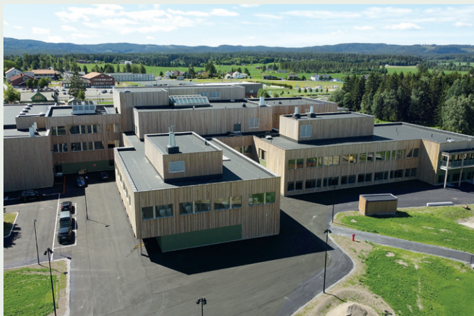
Skolebygget med svømmehall og idrettsanlegg er vel 13.500 kvadratmeter.
